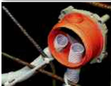
A KBT palástjába szerelt hajlékony csövek.
