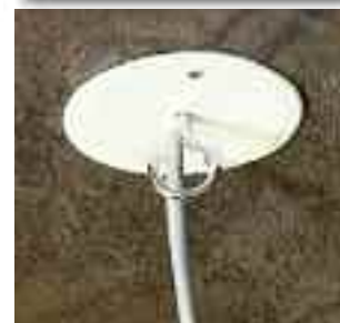
V 68 S fedéllel ellátott KBT... doboz kivezetett kábellel és KBP... csillár-horoggal.
