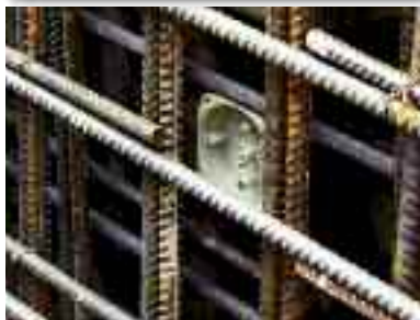
A zsaluzatra erősített KBV fedél.
