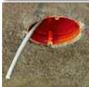
KBT... doboz a KBP... csillár-horog szereléséhez előkészített kivezetett kábellel.
