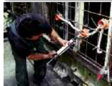
Az átvezetések tömítése (gitt).
